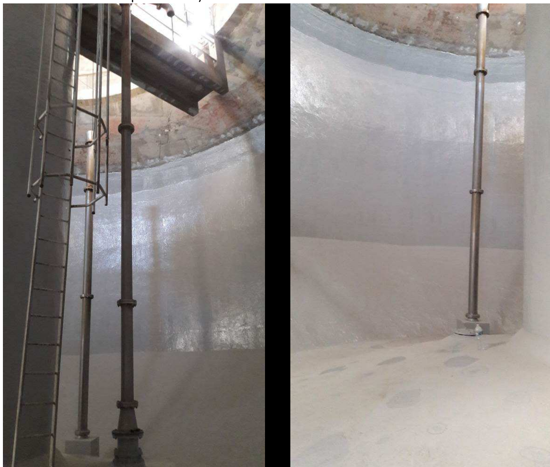
Cuve du réservoir du Montanot
