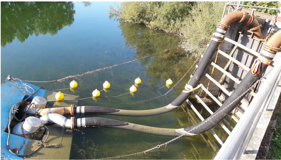
Pompe de secours dans le Doubs – Captage de Mathay
