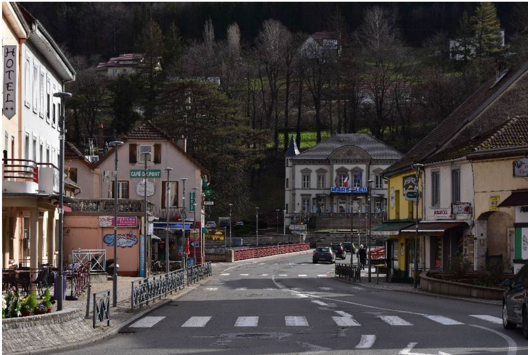
Le pont sur le Doubs élément patrimonial le plus visible et le plus significatif
