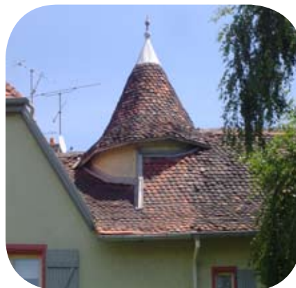
Yorbe du N°4 de la rue de la Sous-préfecture
