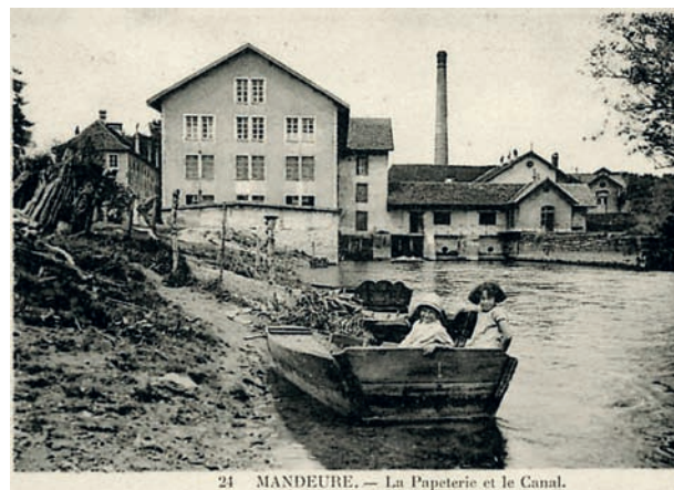
24 MANDEURE. — La Papeterie et le Canal.
