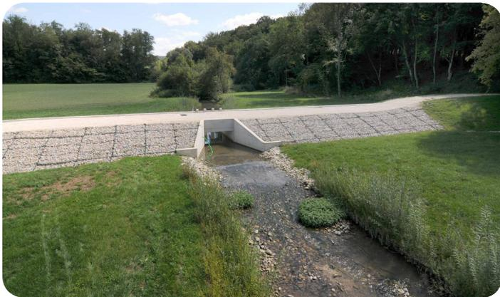
*Barrage à pertuis ouvert\* sur la Feschotte à Dampierre-les-Bois permettant de compenser l'impact hydraulique des travaux de recalibrage sur la partie aval.*
