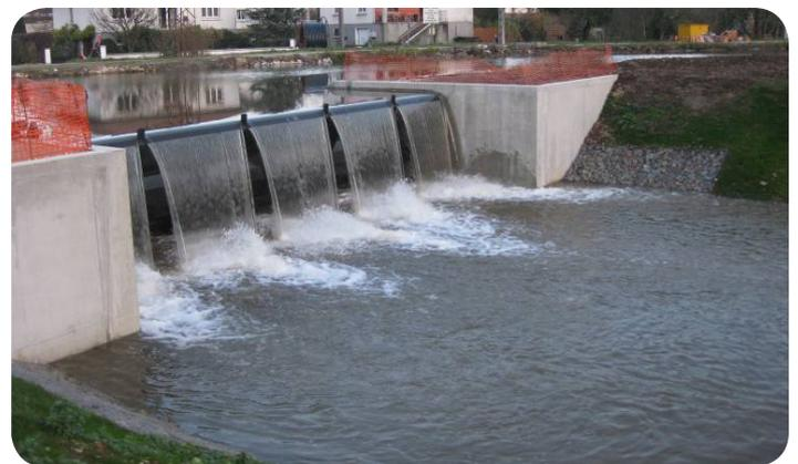
*Clapet de décharge des eaux du canal vers l'Allan à Courcelles-les-Montbéliard*
