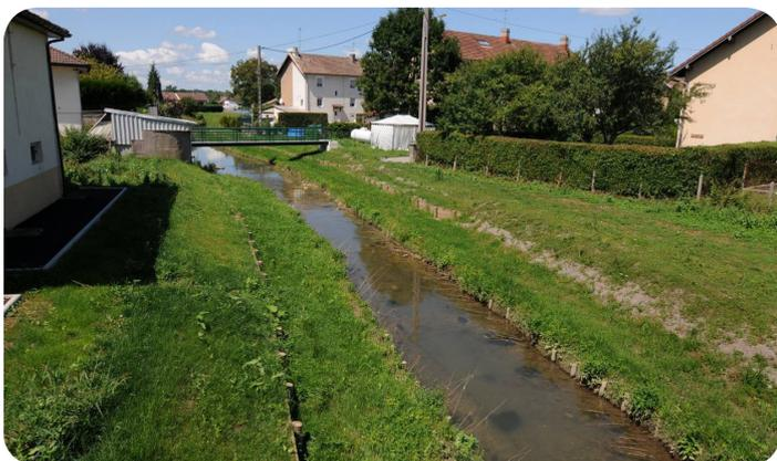
*Restauration d'une plus grande capacité d'écoulement du lit de la Feschotte dans la traversée de Fesches-le-Châtel et réfection des passerelles franchissant la rivière.*
