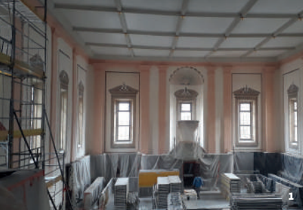
Temple Saint-Martin en restauration
